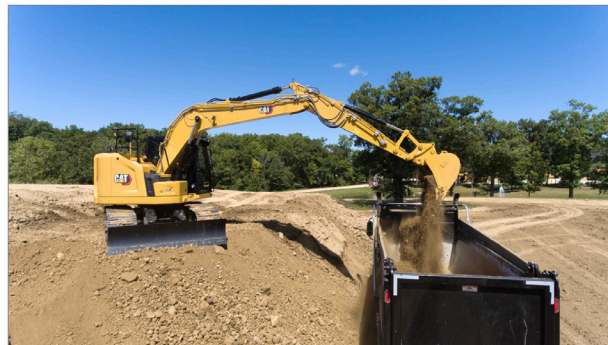
Raupenhydraulikbagger belädt Lkw.
