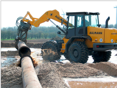
Radlader mit Rohrgreifer
